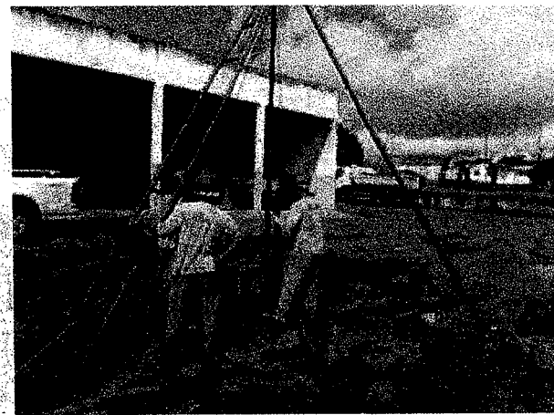
Foto 10 EXECUÇÃO DE SONDAGEM À PERCUSSÃO (SPT).
