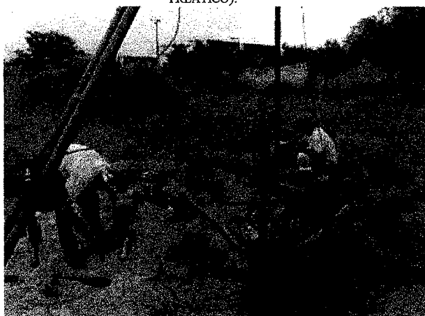
FOTO 15 CONF. PARA SOND. A PERCUSSÃO (VER. NÍVEL DO LENÇOL FREÁTICO).
