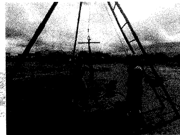
Foto 12 EXECUÇÃO DE SONDAGEM À PERCUSSÃO (SPT).
