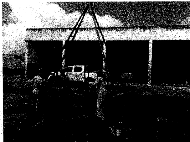
Foto 08 EXECUÇÃO DE SONDAGEM À PERCUSSÃO (SPT).
