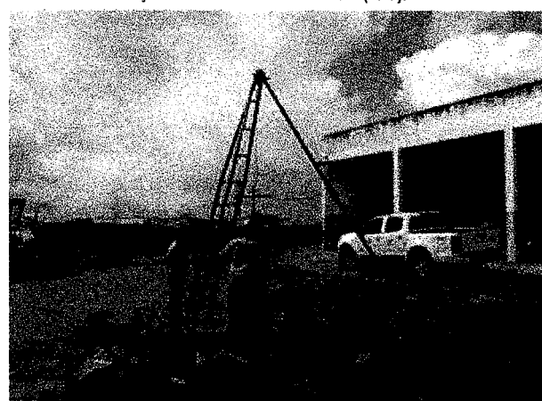
FOTO 06 EXECUÇÃO DE SONDAGEM À PERCUSSÃO (SPT).
