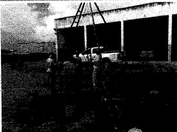
Foto 07 EXECUÇÃO DE SONDAGEM À PERCUSSÃO (SPT).
