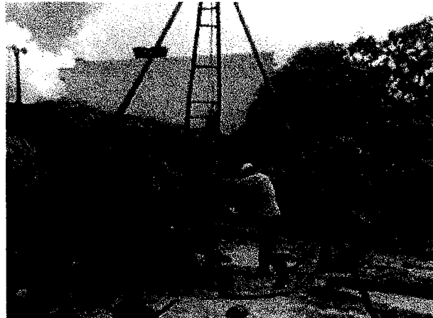
FOTO 02 EXECUÇÃO DE SONDAGEM À PERCUSSÃO (SPT).
