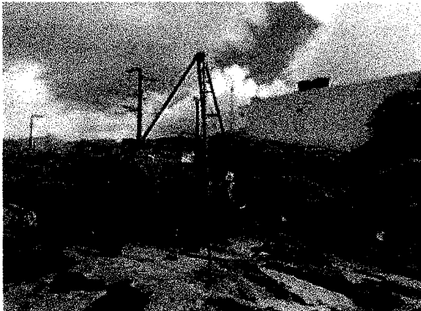
FOTO 01 EXECUÇÃO DE SONDAGEM À PERCUSSÃO (SPT).
